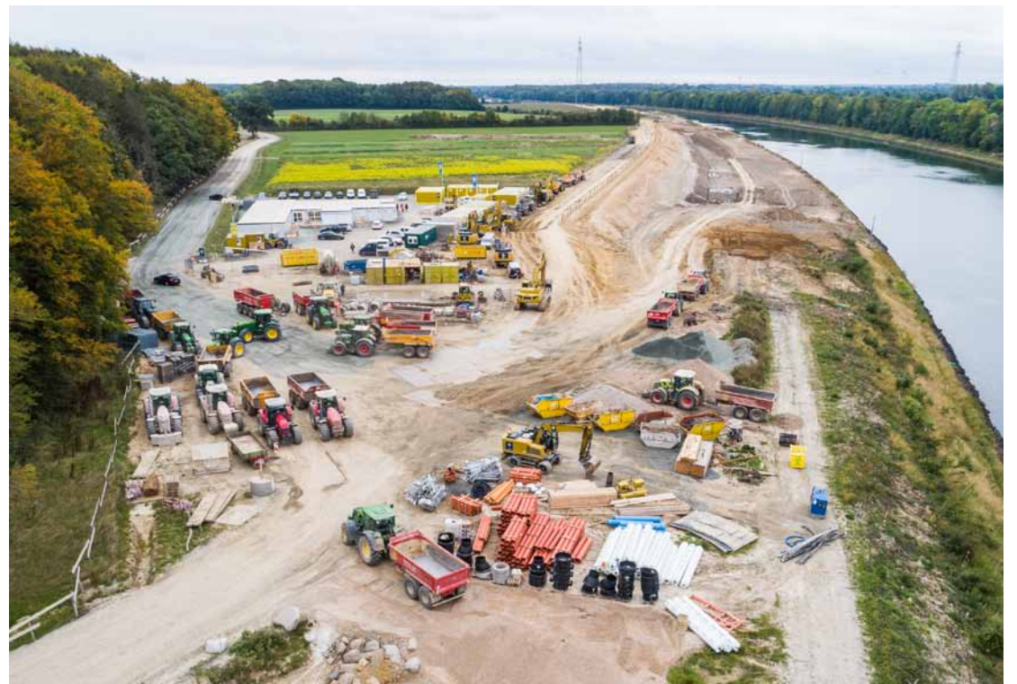
2 500 Meter Baustellenstraßen dienen der Material- und Geräteversorgung.
