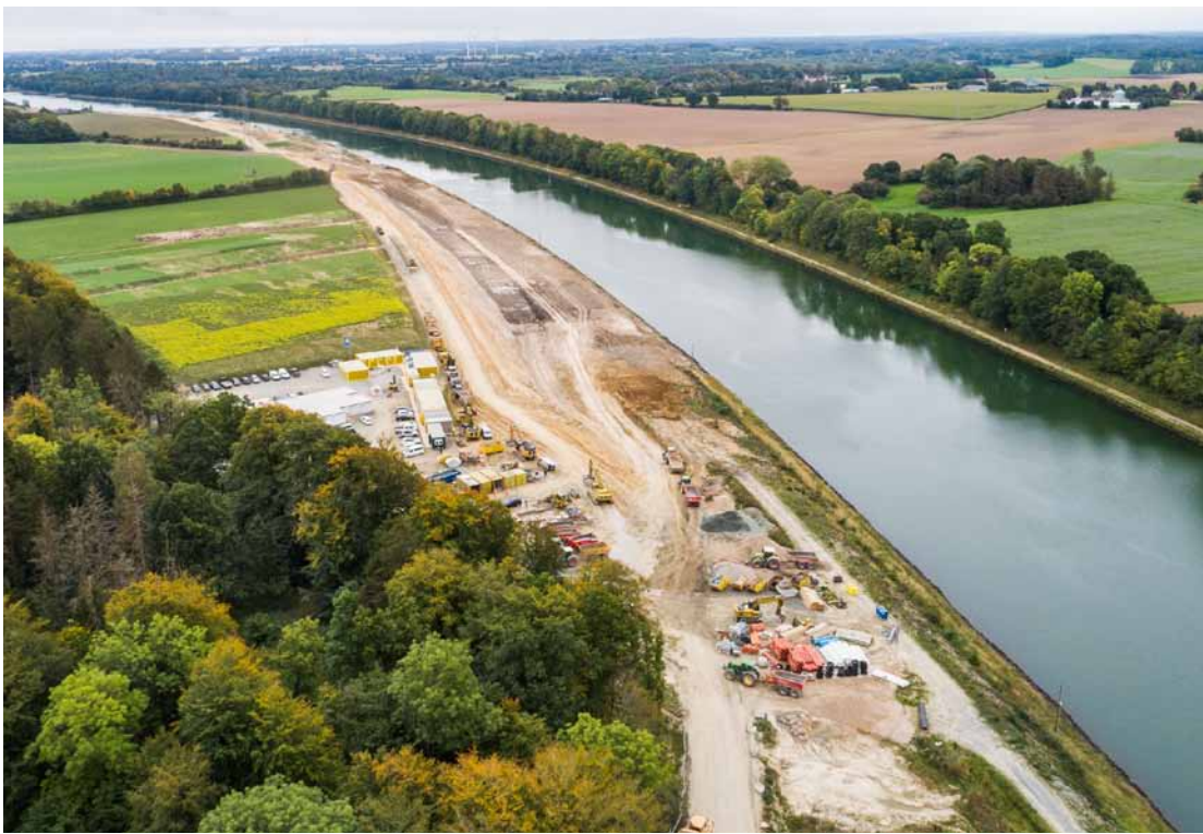
4,2 Kilometer der Ausbaustrecke werden von Depenbrock Bau bearbeitet.
